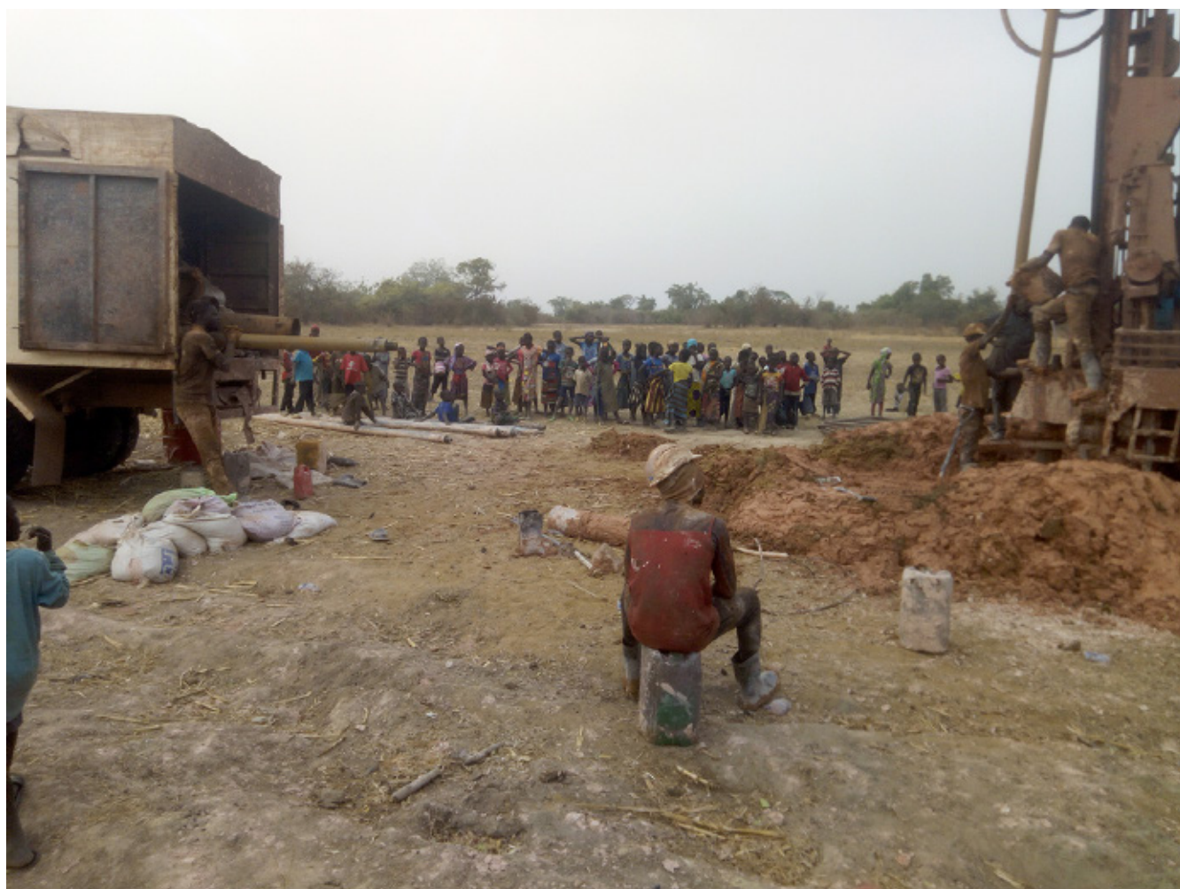
Estas y siguientes, trabajos de perforación.
